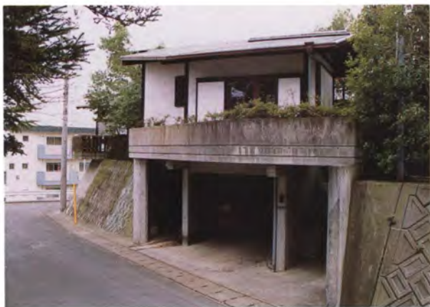
北側〈車庫、老人室〉を見る
