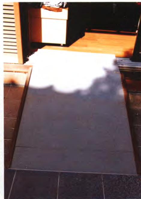
テラススロープ
