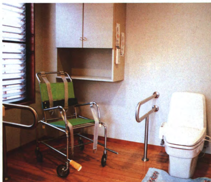
トイレ 車椅子置場も考慮
