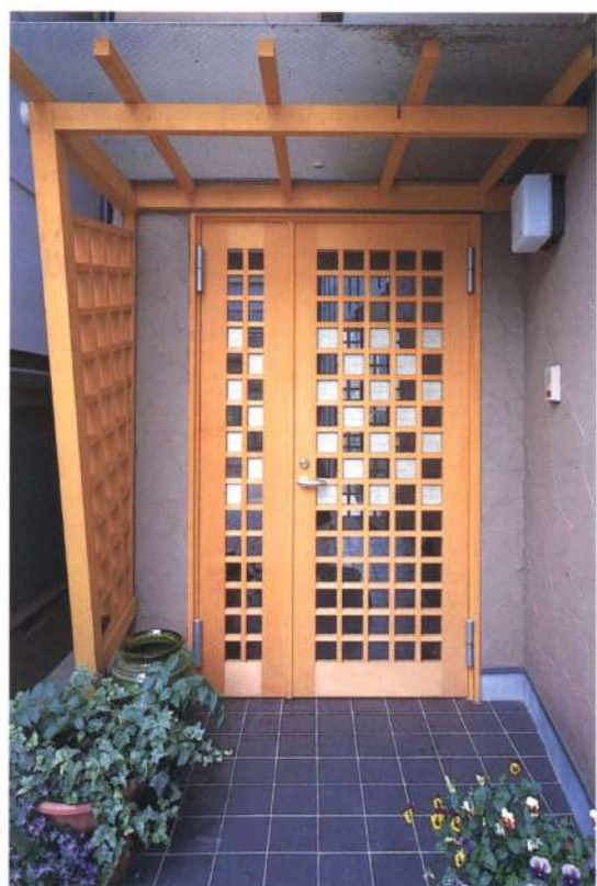
▶玄関扉の格子の升目は家主の手作業によって貼られた葛布。
