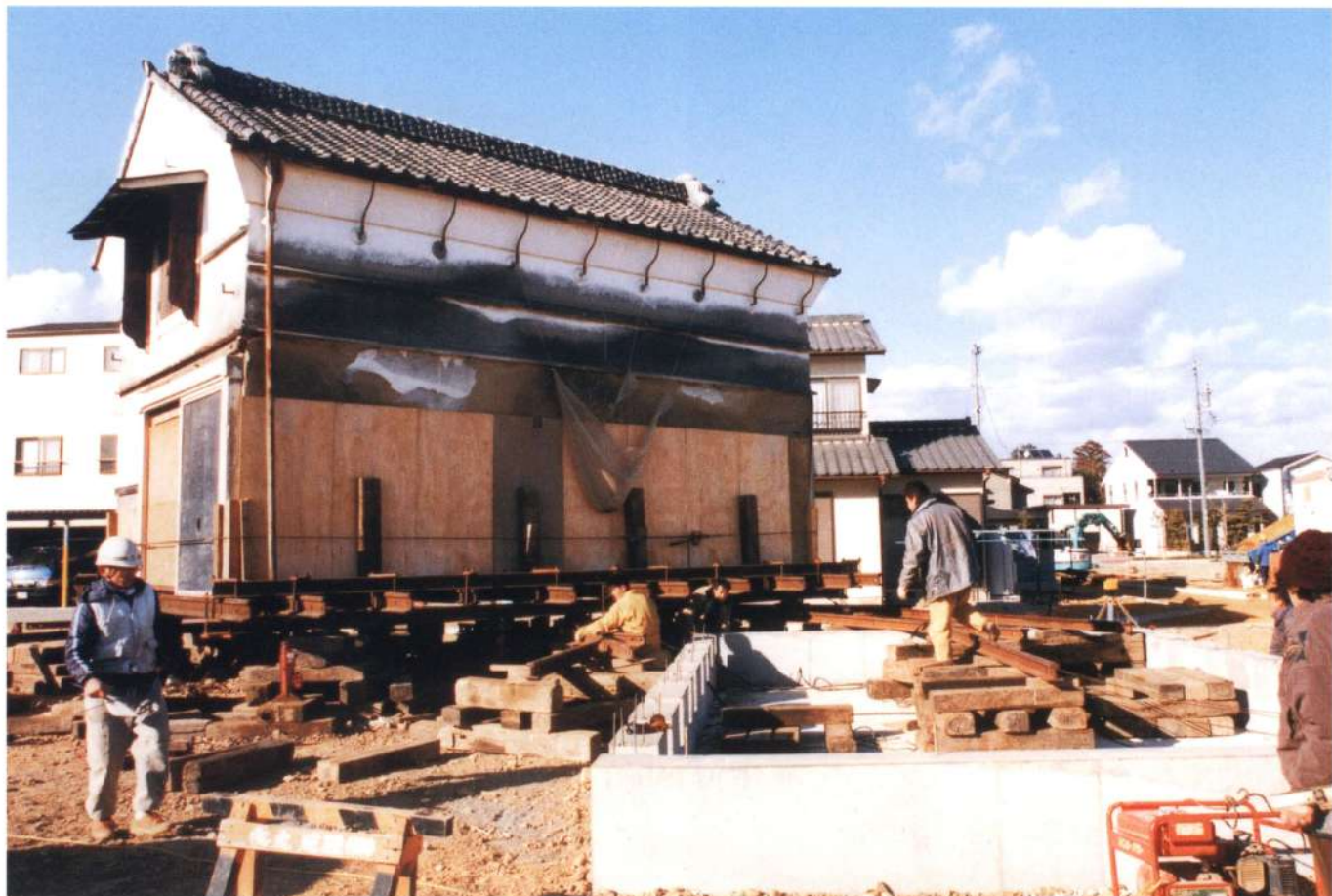
▲換地先へ洩家をさせる蔵の工事全景。
