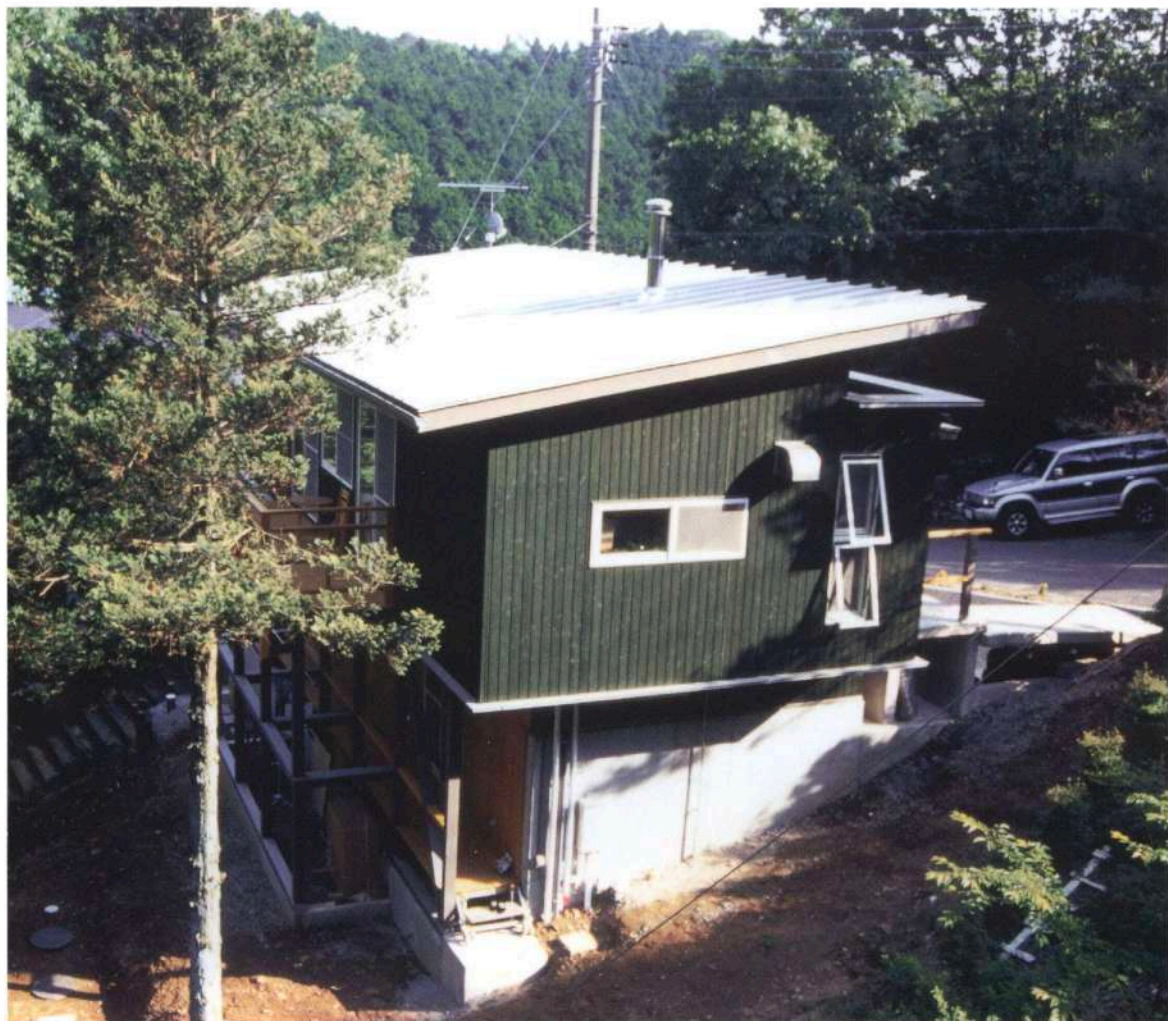
▲北側外観 北側より見下ろす。東下がりの斜面に建つ。
