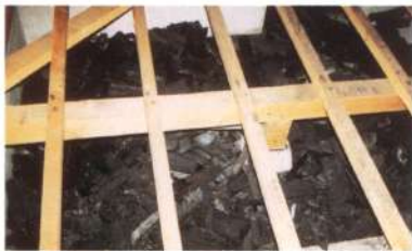
▲ 1F床下 炭敷込み
