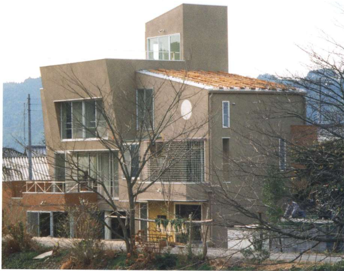
▲北東側外観 緑化の屋根が見える。
