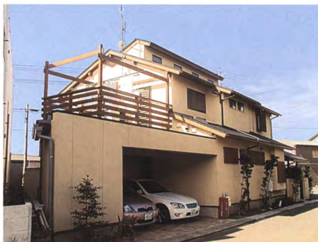
▲北側全景（裏通り側） 表通りからは見えない物干し場は、風通しと日当たり良好。 下は建物と一体の車庫。
