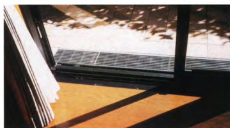
▲外部出入口部分の雨処理
