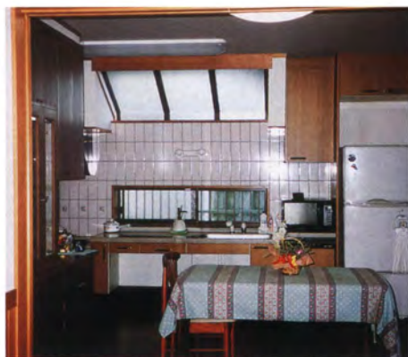
▲吊戸棚不要なためトップライトを設けた厨房上部
