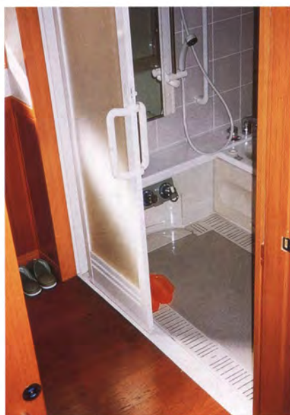
▲浴室入口部分の排水処理
