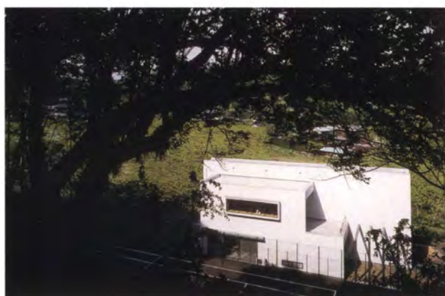
▲外観見下ろし 建物に隣接してテニスコートがある。
