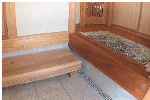
▲玄関・ホール
