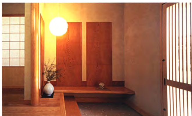
▲玄関脇 古い無垢の天井板を「ゆずられた家」の象徴としてベンチの背面に再利用した。
