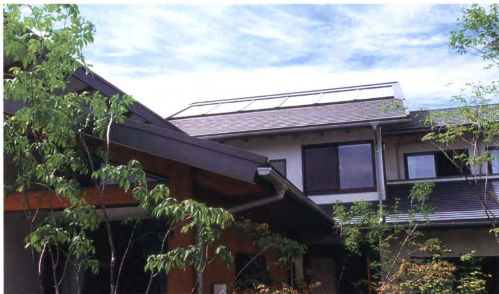
▲屋根 フィッツソーラーで太陽熱を利用した床暖房とお湯採りをしています。
