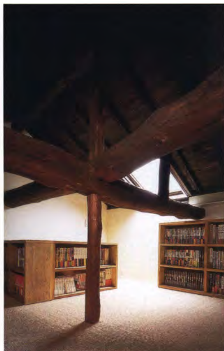
▲屋根裏部屋 開放的な町屋の中で、隠れ家的なプライベートな部屋。
