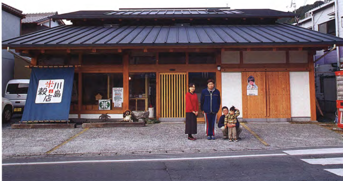
▲正面全景 古い町並みに合せたファサード。
