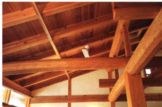
▲店舗小屋裏木組 天竜杉の丸太を利用した力強い小屋組。
