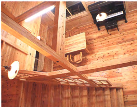
▲食堂・階段 俯瞰
