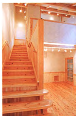
▲アトリエ全景 床・腰・階段は秋田杉ムク材、 壁は寒冷紗貼ベンキ仕上。
