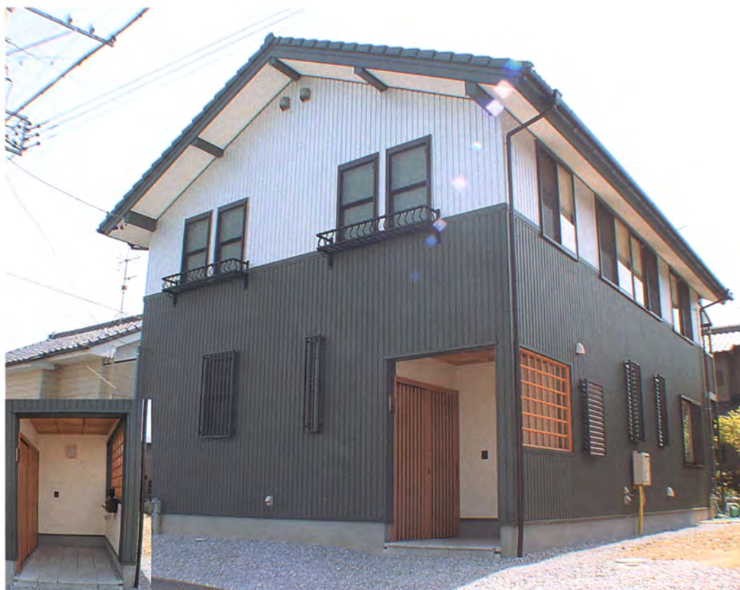
▲北西外観 高耐久、省メンテナンスを重視しました。
