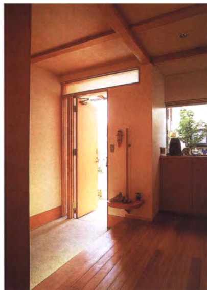
▲玄関 作り付けの手摺と腰掛け。
