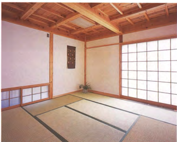
▲1階和室 根太掛けの上に30mmの杉板を貼った天井とし、板の間と雰囲気を変えている。
