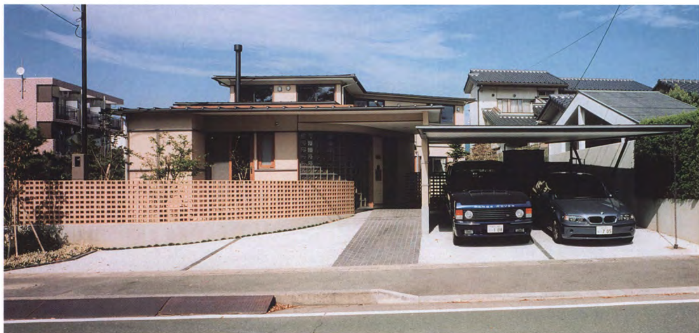
▲外観（正面より）
