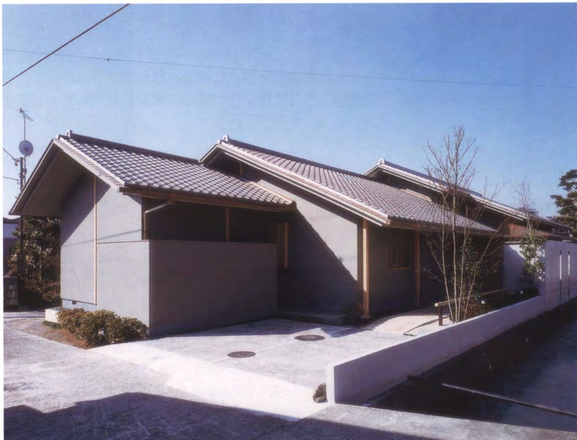
▲北東側外観 右側に中溝川。打放しコンクリート塀は護岸の役目を果たす。
