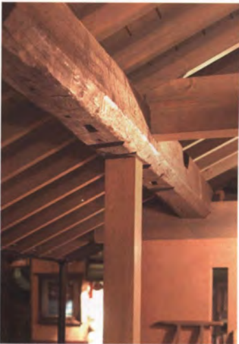
▲店の入口から住宅への軒先は、古い家からの古材梁を再利用しました。
