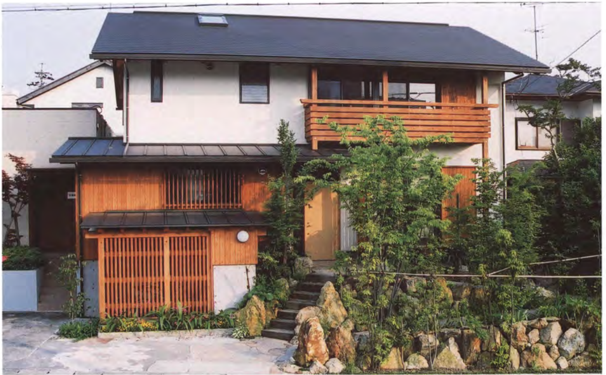
▲北側外観 延焼線のかからない部分を杉板壁とし、バルコニー、雨戸戸袋を杉で造っている。
