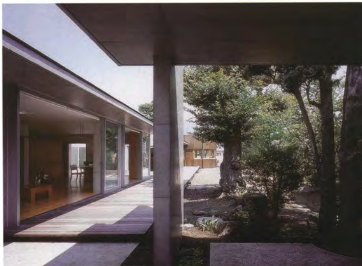
▲キャノピーより見る ウッドデッキをはさんで椎の木と居間、食堂が向かい合う。
