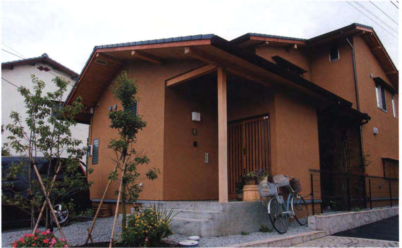
▲正面（北側）外観 道路に面した北側部分は、平屋とし、まちなみに圧迫感を与えない外観としました。南側には庭を確保しながら建物をセットバックして、東側のお隣への日照を妨げないように心掛け、室内に風や太陽光を採りこむようにしています。
