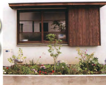
事務室の窓部分の外観。
