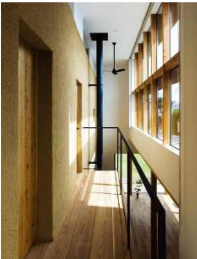
吹き抜けに面した土壁に太陽日射熱を蓄熱させる
