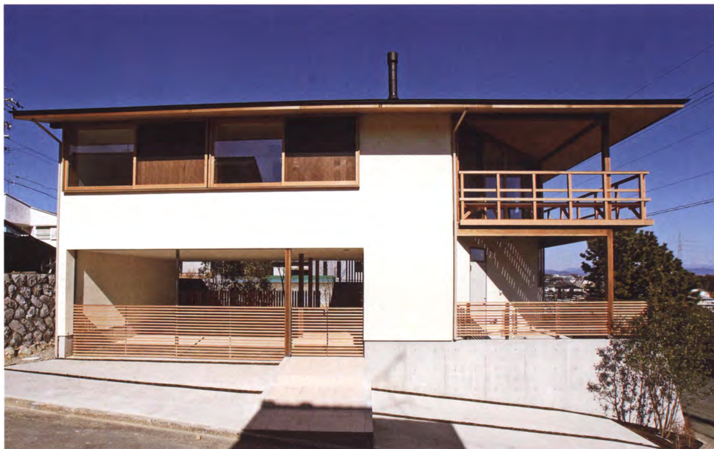
南面外観—既製品を使わず、木製窓・ガレージシャッター等をシンプルで大きな屋根で守っている
