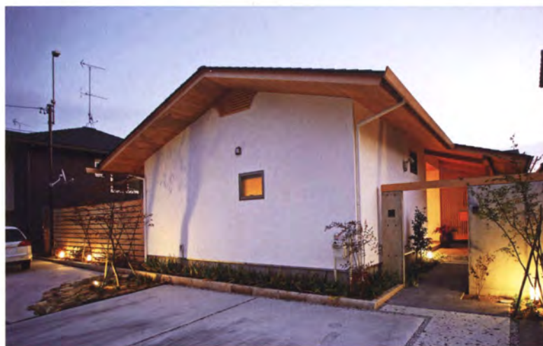
北側外観 ハナミズキがライトアップされ、白い外壁に影を落とし、幻想的な世界を演出してくれる。
