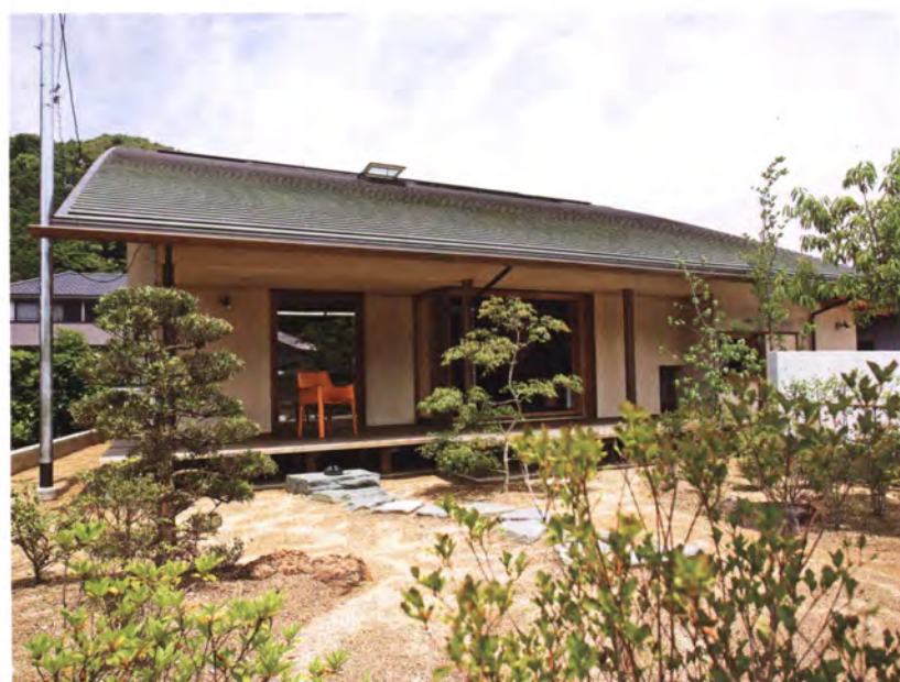
南東からの外観：庵のような佇まいを意識した屋根の最上部には、パッシブソーラーによる集熱パネルが設置されている。
