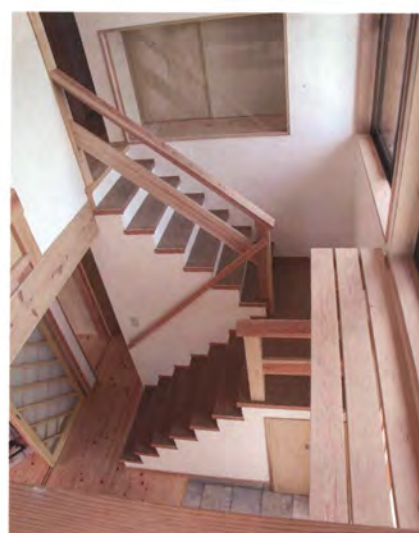
▲2世帯のつながりを持つ階段ホール
