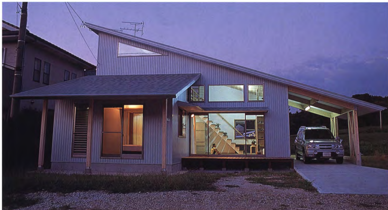
▲南側外観 向かって右側駐車スペース、脇が玄関、中央にリビング、左手前が寝室、上部三角トッブライトが2階子供室。
