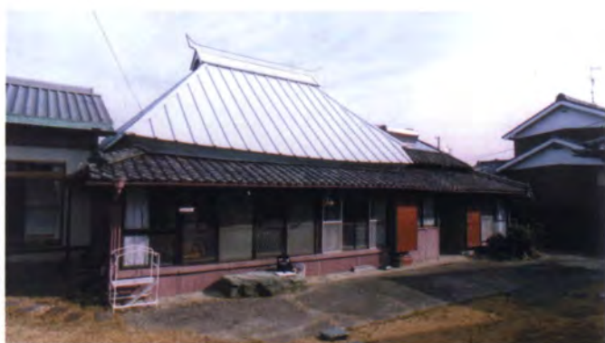
再生前 茅葺き屋根はトタンが被せられていました。
