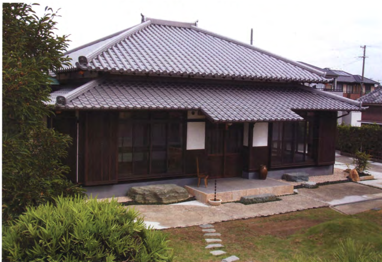
南側外観 茅葺き屋根部分は、本瓦葺きのむくり屋根と姿を変えました。 庇は棧瓦葺き、外壁は小舞荒壁下地漆喰塗りです。
