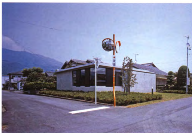
南西より望む | 古くから残る住宅街の角地に立つ。
